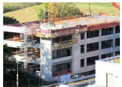
Das im Bau befindliche Bildungszentrum.
